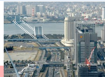
国道357号 東京港トンネル
