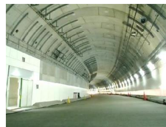
首都高速中央環状品川線 本線シールド 施設施工状況
